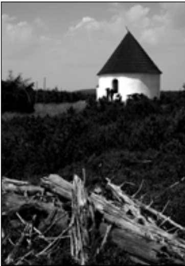
Kunštátská kaple stojí přímo na hlavním hřebeni ve výšce 1035 metrů
